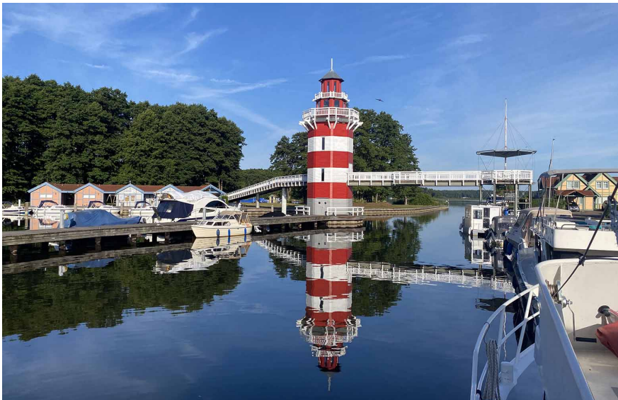
Der Leuchtturm in der Hafeneinfahrt von Rheinsberg.
